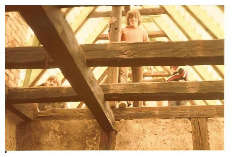
Ein Stockwerk höher im oberen Spitzboden müssen auch noch die Böden mit neuen dicken Nut-und-Feder-Brettern belegt werden.
